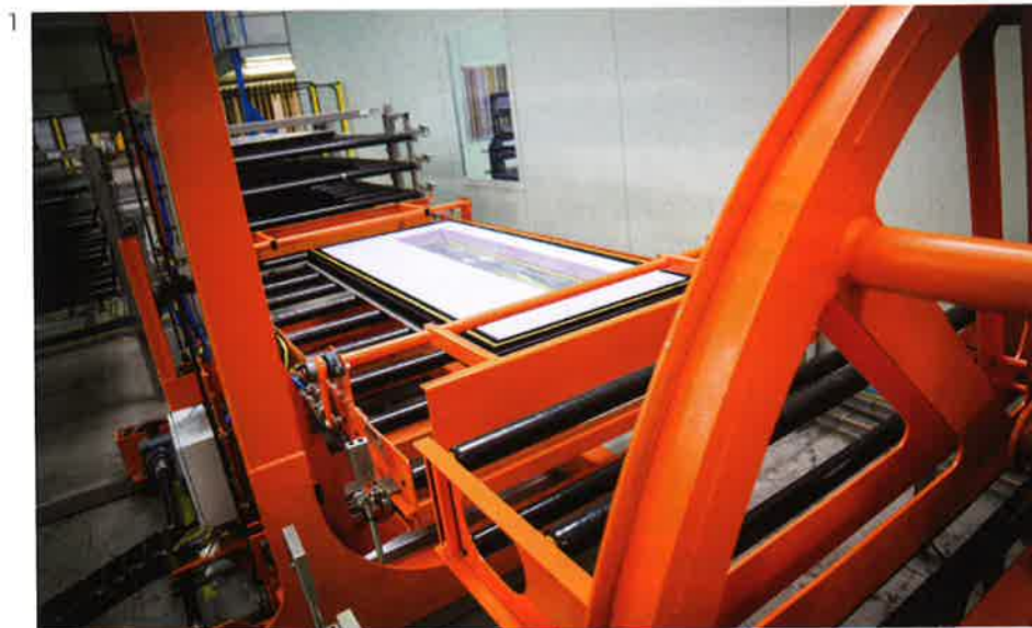
1 Convoyage automatisé des ouvrants monoblocs.
